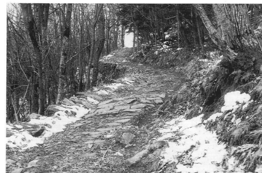
La sede stradale, poco a sud di Pavana, in prossimità del punto 41 della fig. 2.
