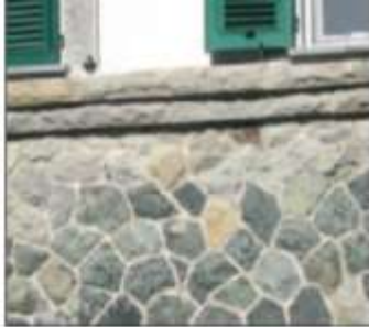
Foto 9 - Esempio di rivestimento murario (S. Maria del Taro, PR)
