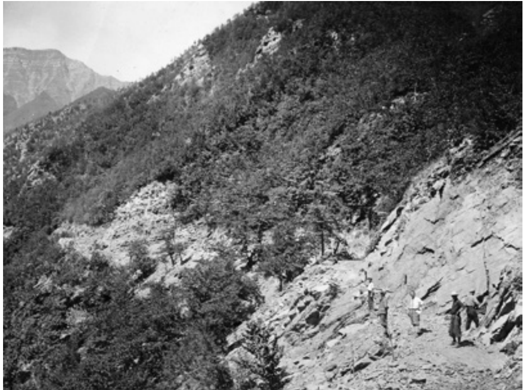
26.1 – Lavori preliminari per la costruzione del piano di fondazione della strada Segavecchia - Pianaccio (Lizzano in Bevedere, Bologna) negli anni 1933-34.
