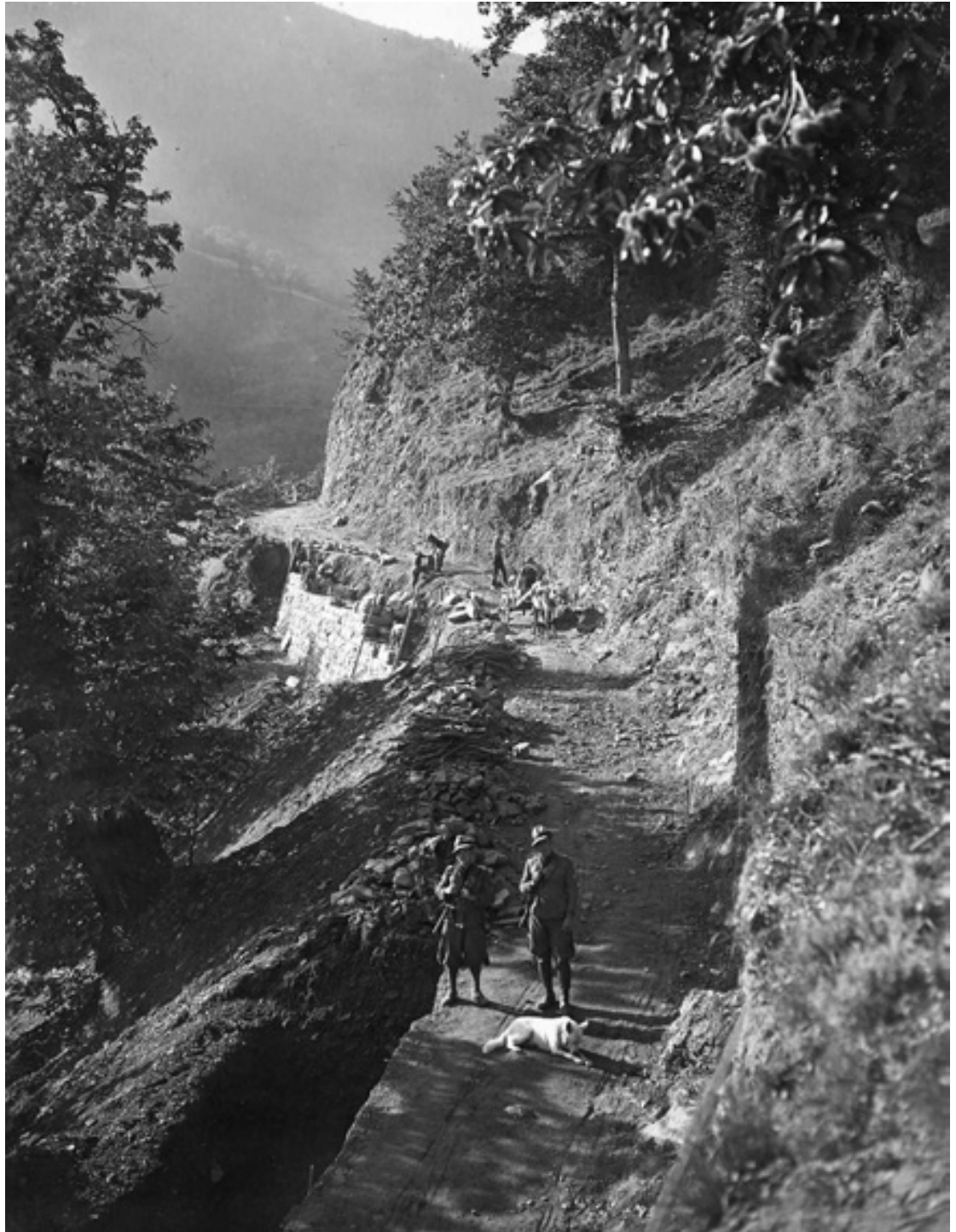
10.1 – Due Militi Forestali in perlustrazione ai lavori per un piano stradale.
