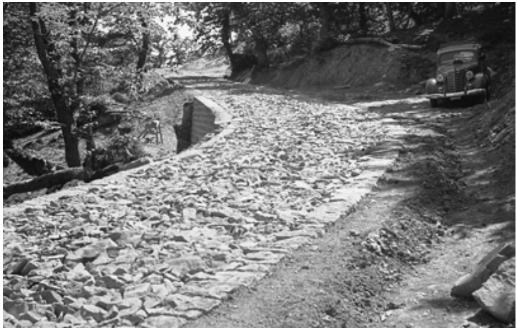
26.2 – Realizzazione in pietra del piano stradale in località Boccadirio (Castiglione dei Pepoli, Bologna) negli anni Cinquanta del secolo scorso.
