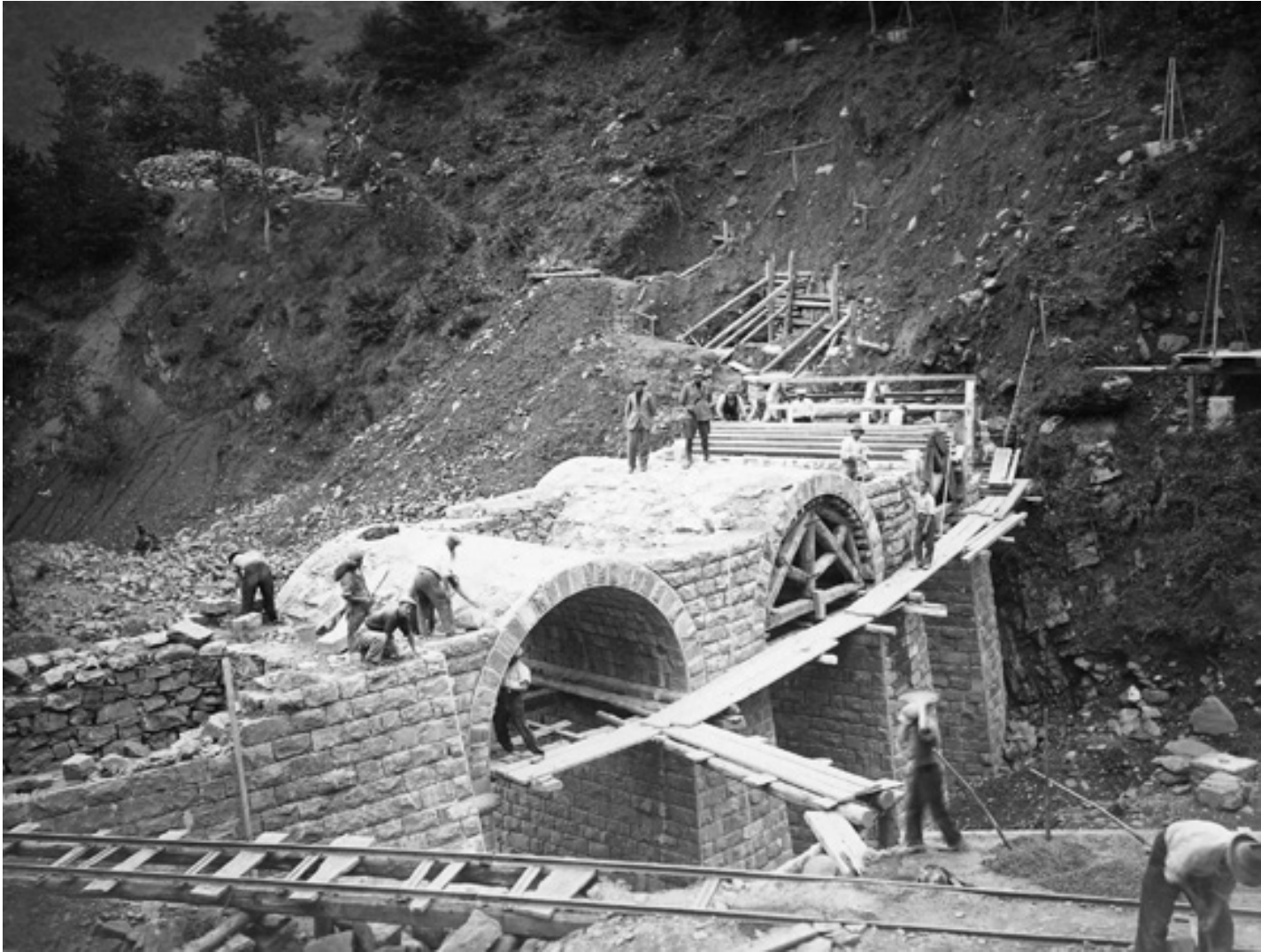
26.3 – Costruzione del ponte dei Bagnadori a Lizzano in Belvedere (Bologna) negli anni 1933-34.
