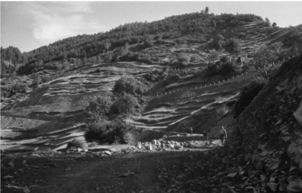
27.3 – Sistemazione a gradoni di un pendio per favorire le operazioni di piantumazione in località Lizzano in Belvedere (Bologna).
