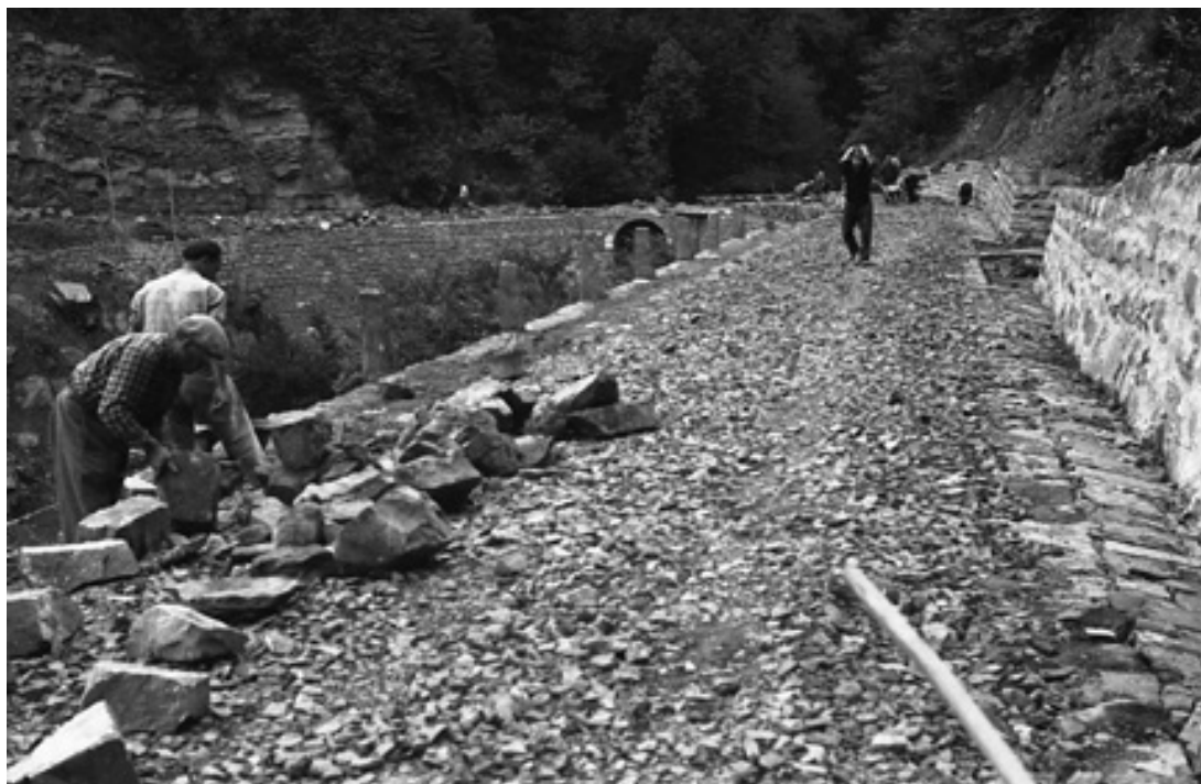
22.4 – Lavori di costruzione della strada Monte Cavallo - Case Calistri - Pianaccio (Alto Reno Terme e Lizzano in Belvedere, Bologna) nel 1956.
