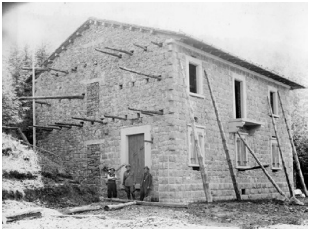
26.5 – Lavori di costruzione della Caserma forestale di Madonna dell'Acero (Lizzano in Belvedere, Bologna) all'inizio degli anni Trenta del secolo scorso.
