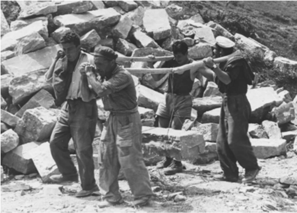
22.2 – Trasporto di conci di pietra per la costruzione, negli anni Cinquanta del secolo scorso, di briglie sul Fosso Rio Raggio a Santa Sofia (Forlì-Cesena).
