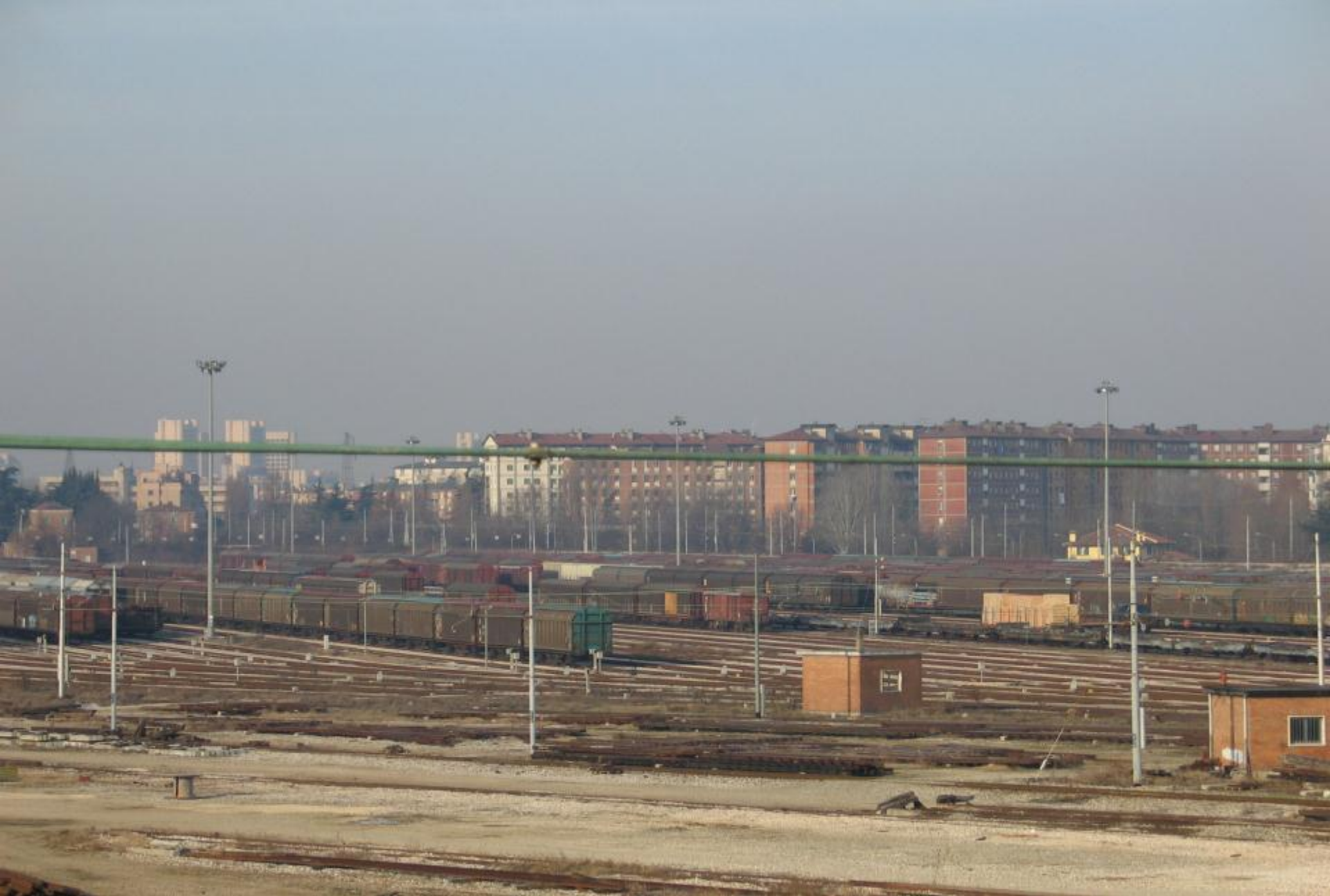
1222 - Rf - Reti ferroviarie - Bologna foto di Stefano Corticelli 02/2006
