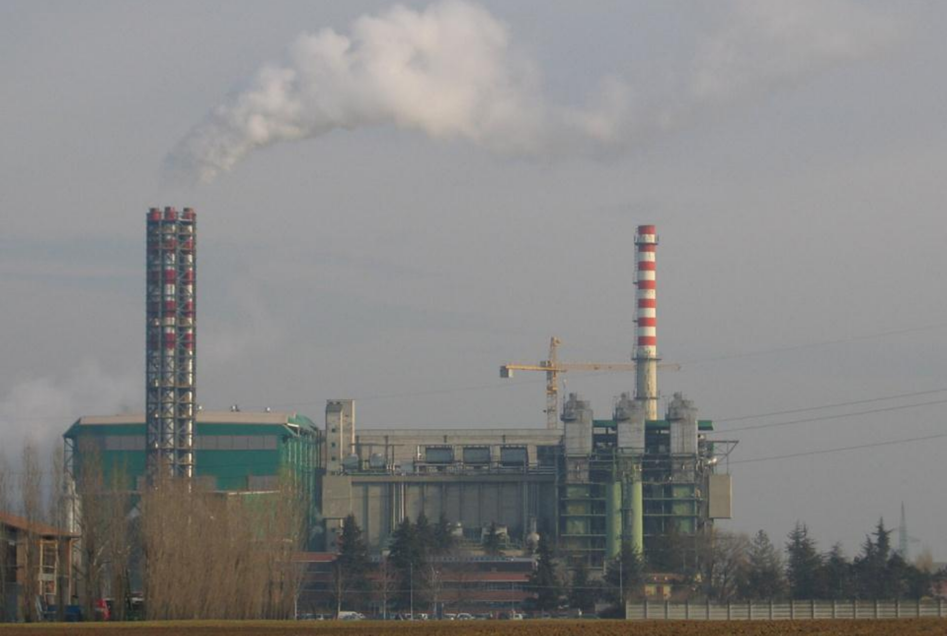
1215 - It - Insedimenti di grandi impianti tecnologici - Granarolo dell'Emilia (BO) foto di Stefano Corticelli 02/2006
