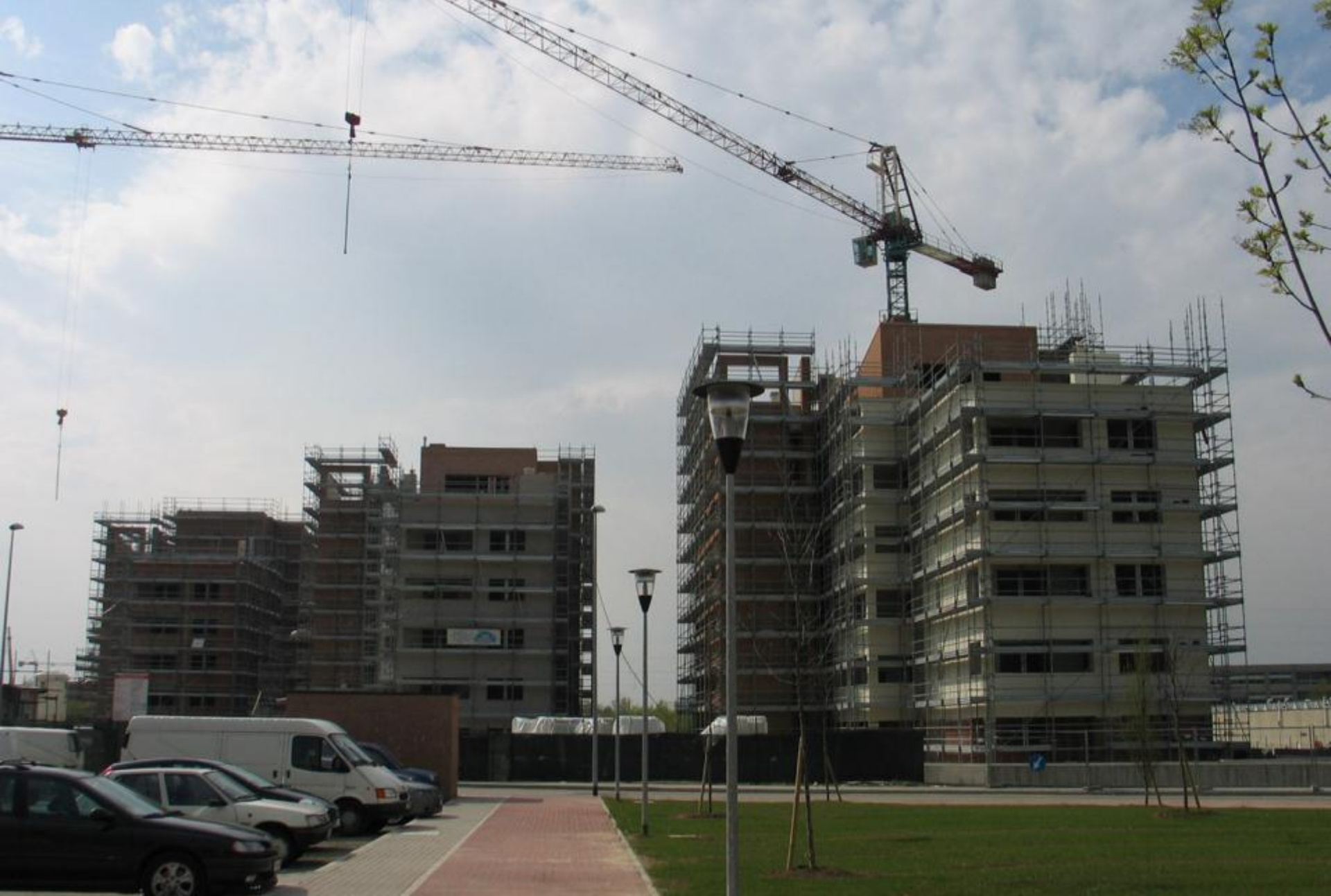
1331 - Qc - Cantieri, spazi in costruzione e scavi - Casalecchio di Reno (BO) foto di Stefano Corticelli 04/2006
